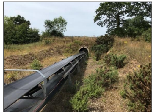
Passage souterrain permettant la traversée du CR n°16 pour le convoyage des matériaux
